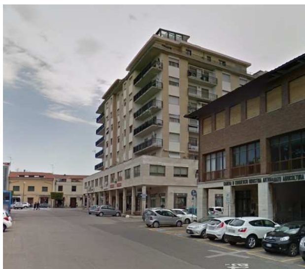
Edifici in Piazza della Libertà lato sud
