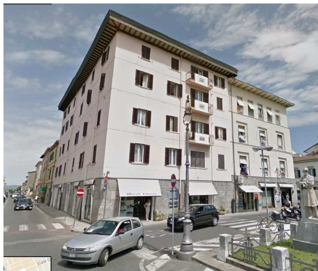
Edifici in Piazza della Stazione
