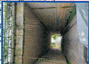
PONTE SU VIA PO
