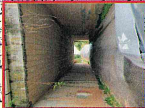
PONTE SU VIA TRONTO
